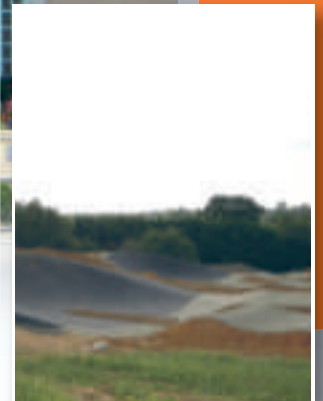
P4 Les travaux du BMX
